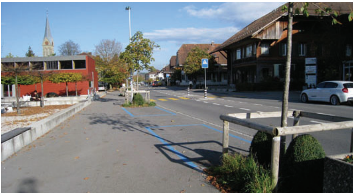
Vorbildliche Strassenraumgestaltung vor dem Schulhaus Paul Klee. Dieses Prinzip soll auch an anderen Stellen angewendet werden.
